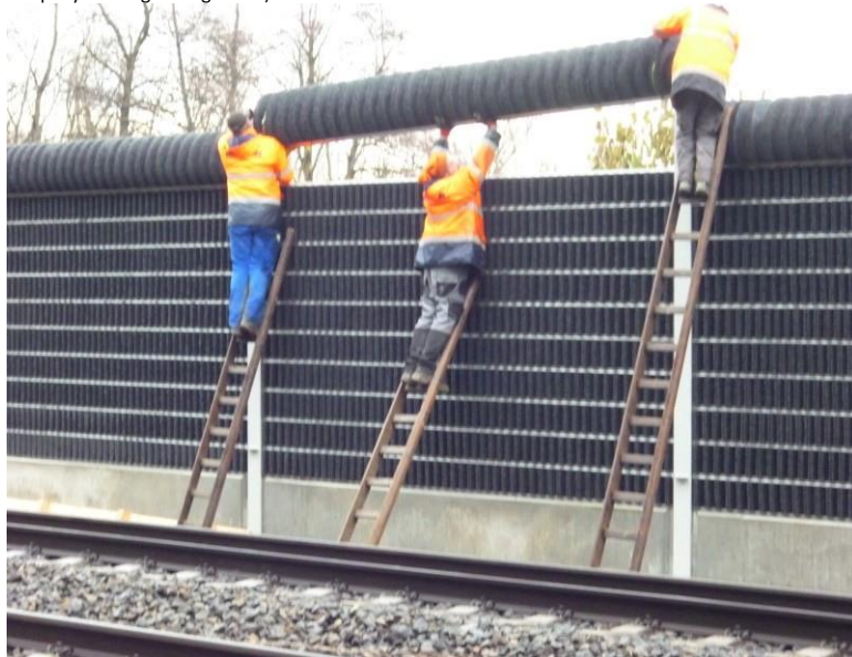
A PIN A Lärmspoiler® kézi felszerelése vasúti forgalom mellett, vágányzár nélkül
