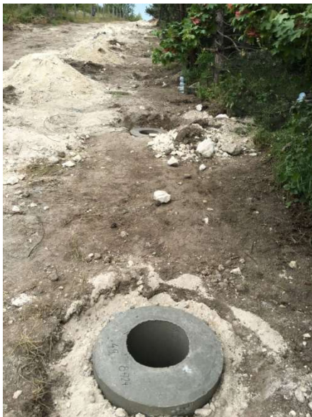
Kibetonozott alaptest, kehelykiképzéssel tartóoszlop számára
