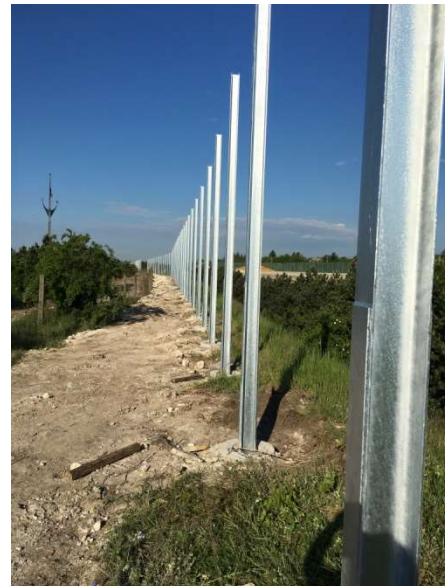
Oszlopállítás - Jól láthatók az öveken alkalmazott erősítések
